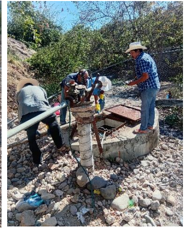
Mantenimiento a la bomba del cárcamo de rebombeo, barrio Linda Vista.
