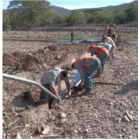
Reparación de tubería en la localidad de Contadero, con tubo de 2"
